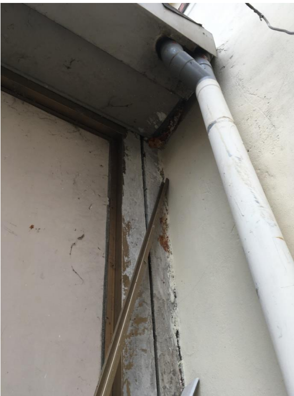
Viste della fessura fra annesso ed edificio adiacente: lato est
