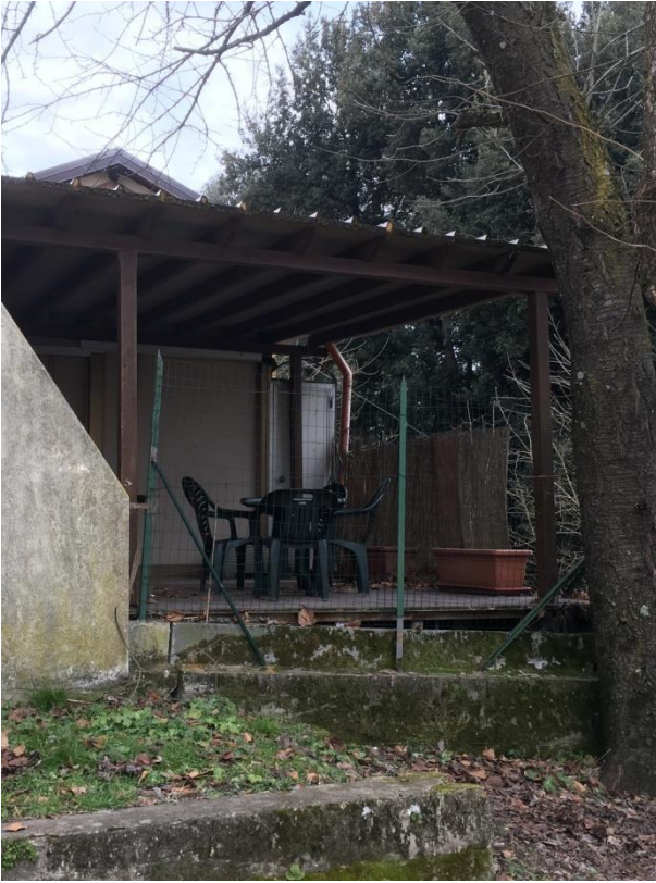
Viste del gazebo adiacente al bar e della sua trave di fondazione, ruotata verso il basso
