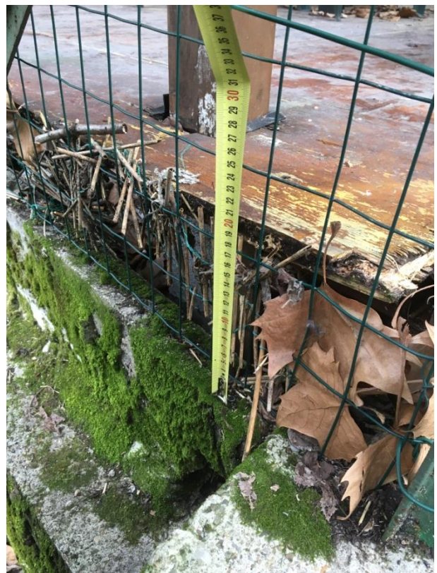
Dettagli della trave di fondazione traslata e ruotata verso il basso
