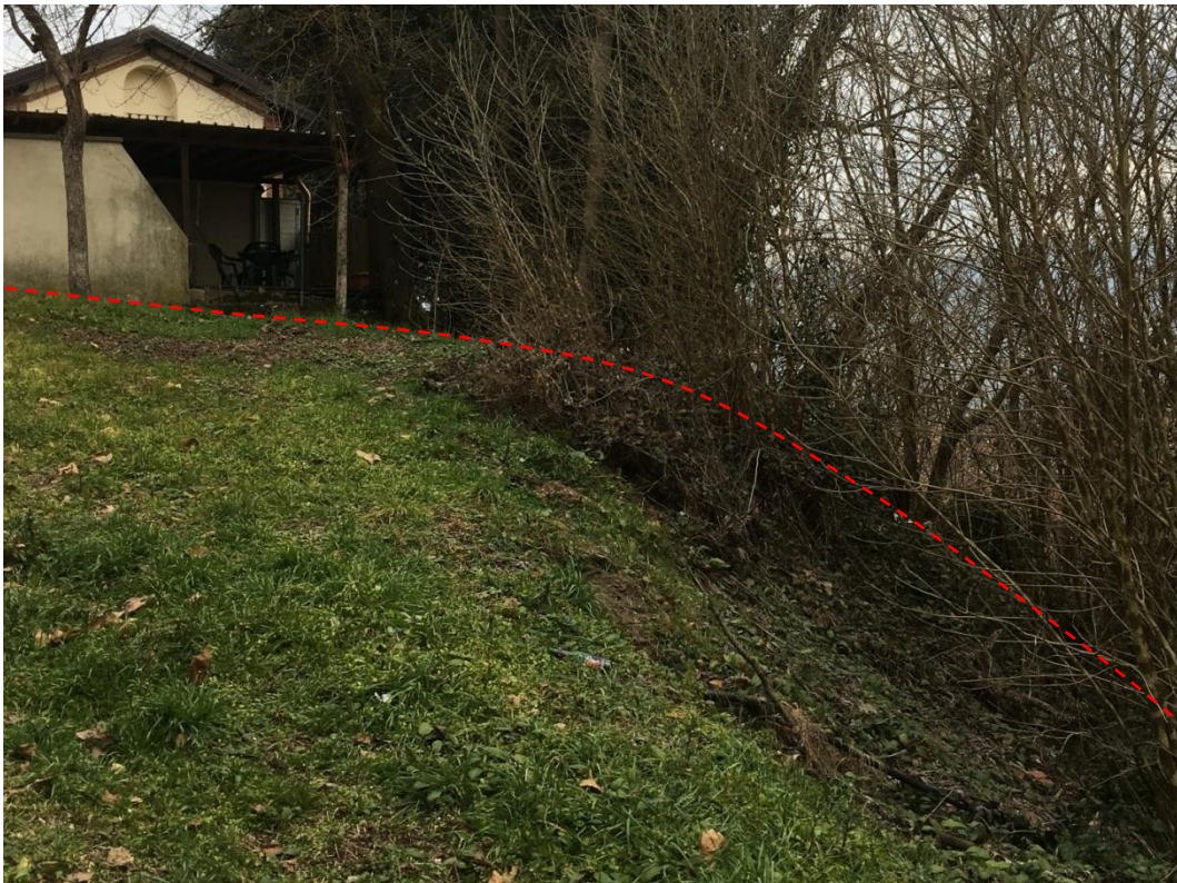
Vista della scarpata in corrispondenza del bar
