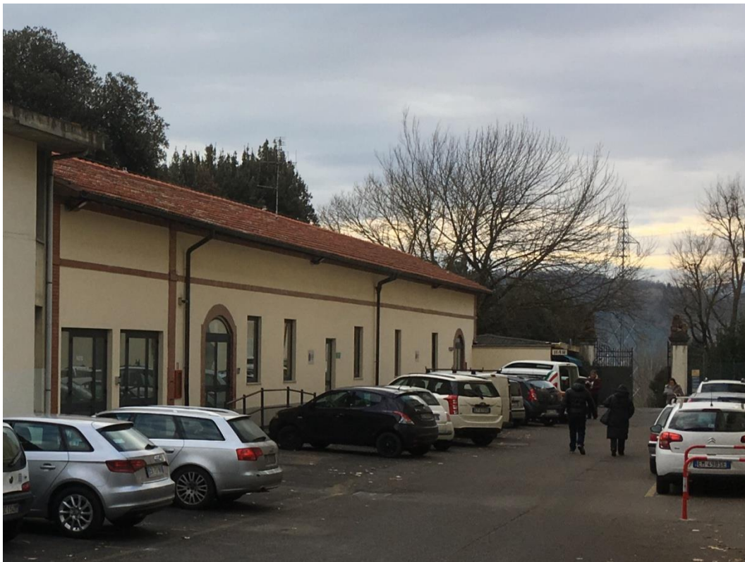
La stecca che ospita i magazzini e il reparto Emodialisi; sullo sfondo l'annesso del bar
