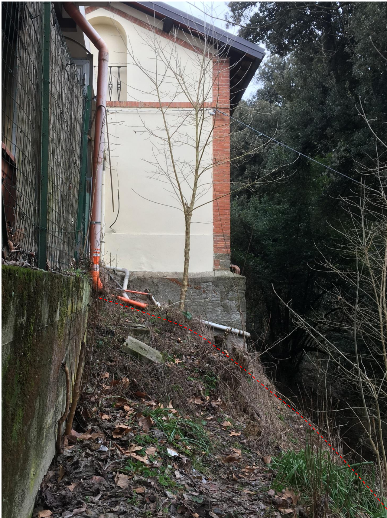
Andamento del riporto di terreno su cui è posizionato il locale bar
