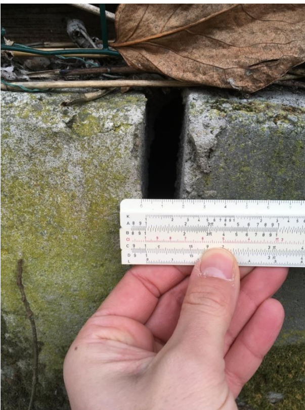
Dettagli della trave di fondazione traslata e ruotata verso il basso
