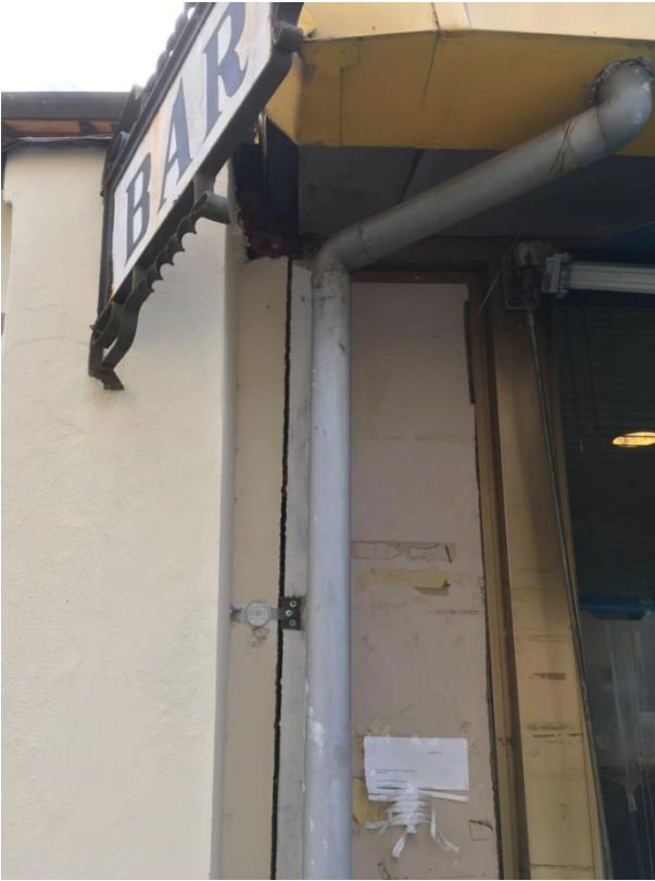
Viste della fessura fra annesso ed edificio adiacente: lato ovest
