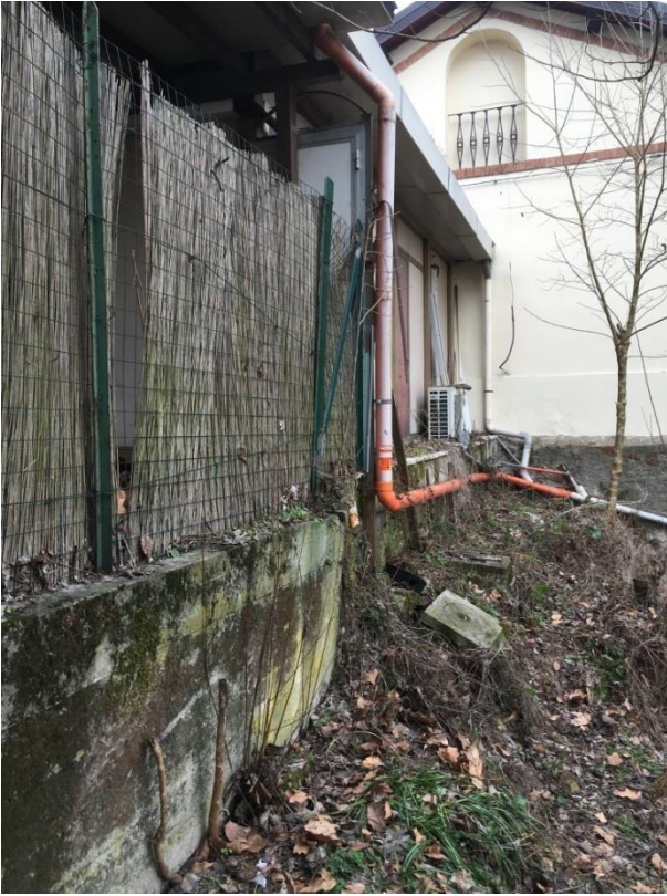
Il gazebo ed il lato est del bar, con visibile la soletta in c.a. ed il magrone in cls.
