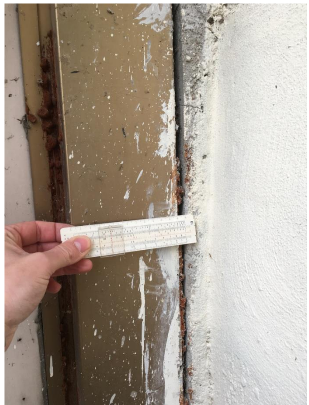
Viste della fessura fra annesso ed edificio adiacente: lato est
