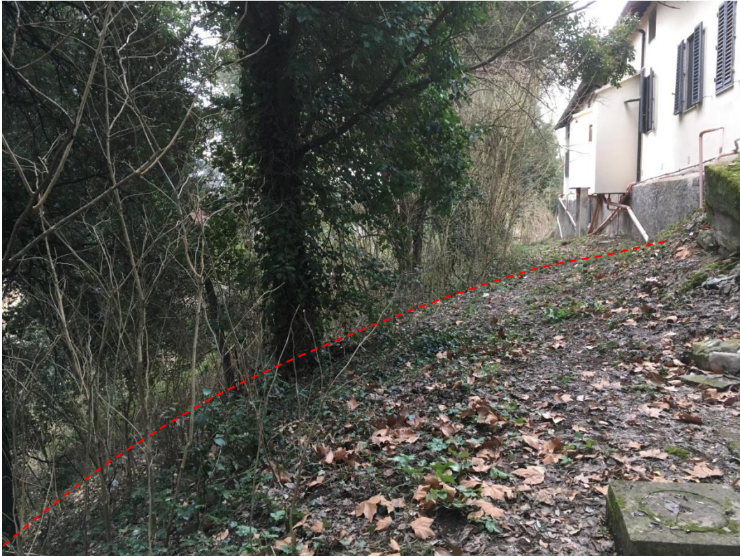
Vista della scarpata naturale su cui insiste la stecca che ospita il reparto di Ematologia
