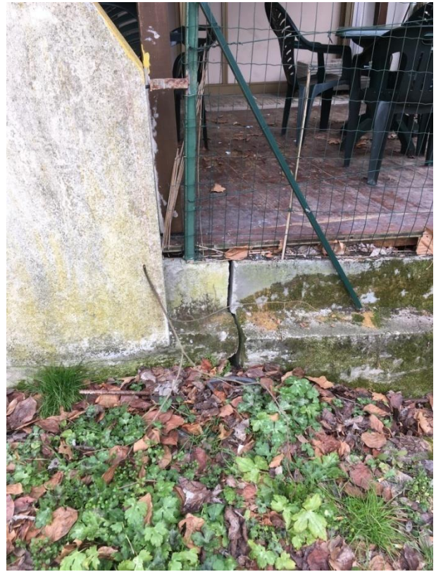
Viste del gazebo adiacente al bar e della sua trave di fondazione, ruotata verso il basso
