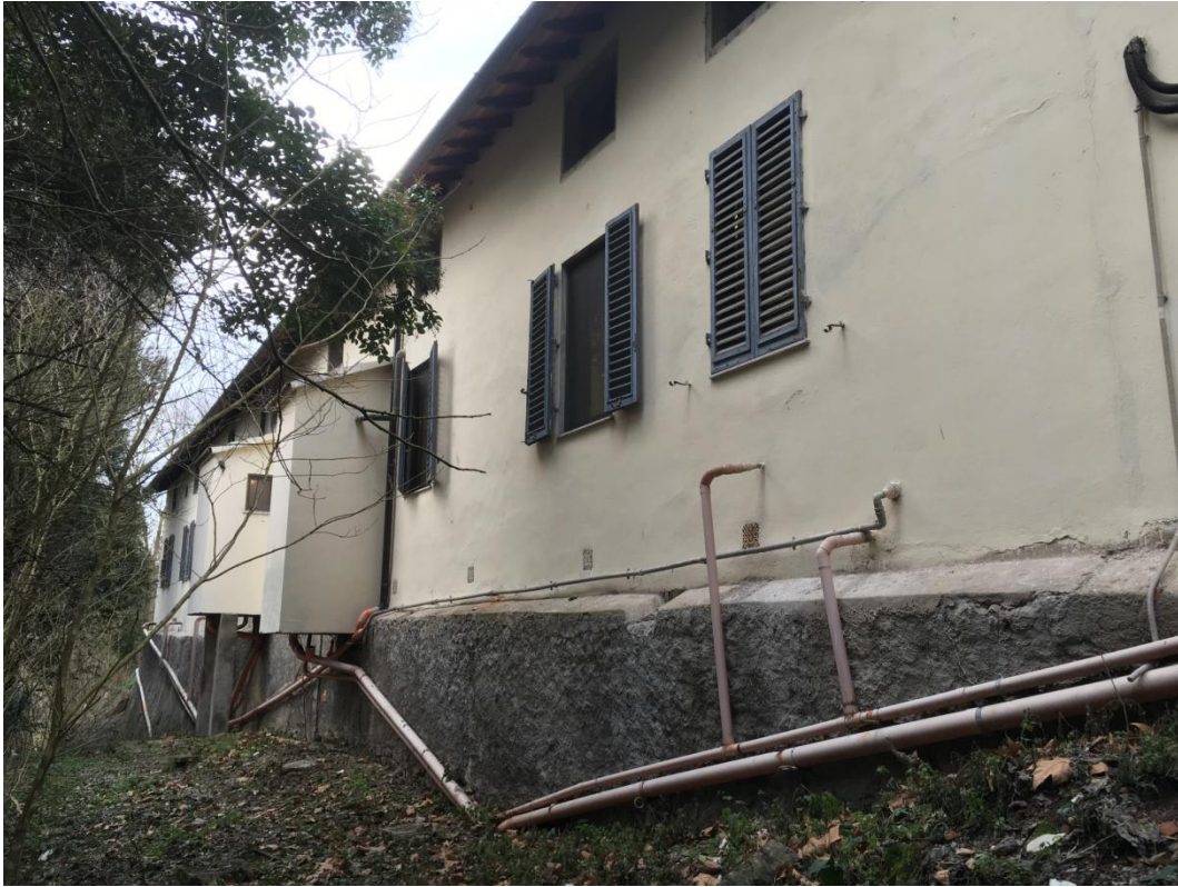
Sopra e in basso a sinistra: lato est dei magazzini e reparto Emodialisi
